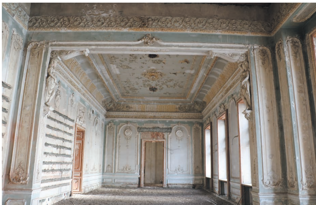
Vila urbană Herța, interior, situația 2022.
