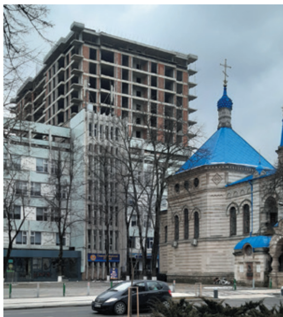
Biserica „Sf. Teodora de la Sihla”, imobil în construcție. Foto: M. Șlapac.
