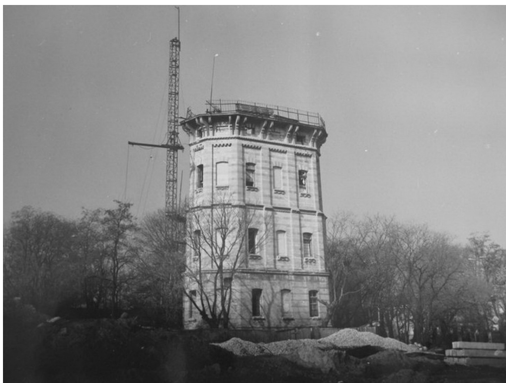
Fig. 12a. Reconstrucția turnului de apă nr. 1, 1980. Arhitect Robert Kurt.
