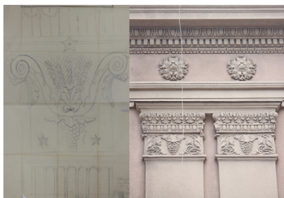
Fig. 13. Capitel al pilastrului.
