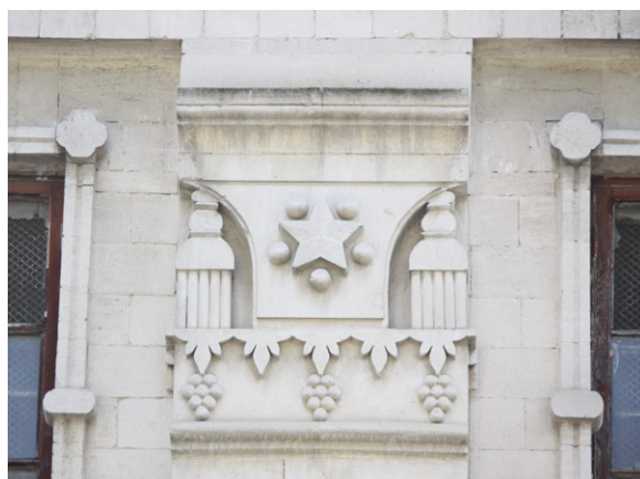
Fig. 27. Capitel a pilastrului. Fațada principală.
