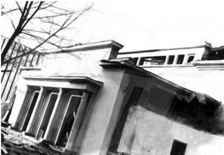
Fig. 9. Începutul demolării clădirii fostului Teatru „Scala”, Bălți, 1977 [16].
