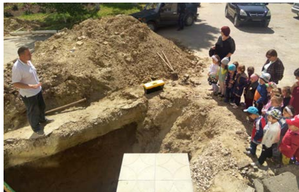
Fig. 17 Galeria de lângă sediul Procuraturii Cahul.
