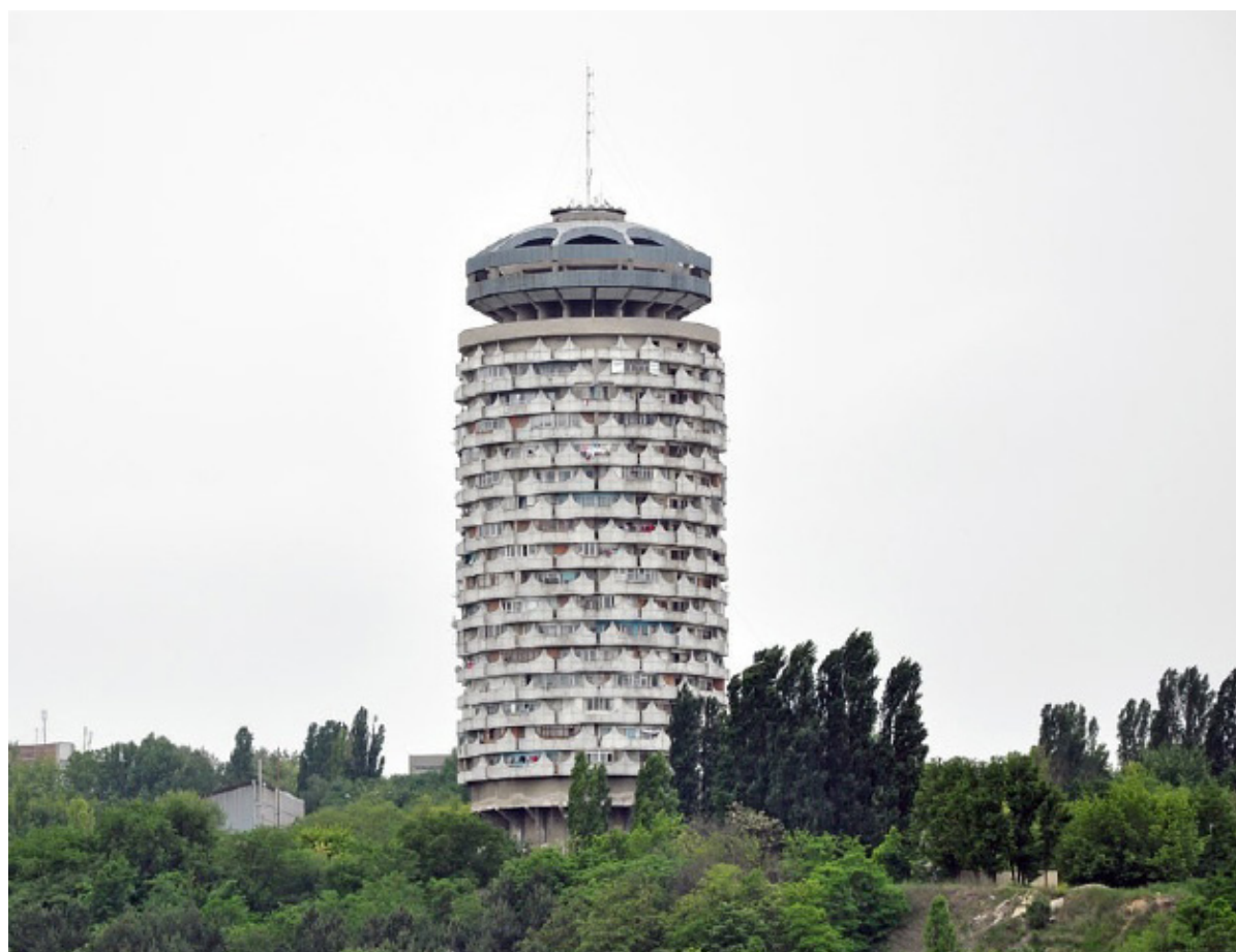
Fig. 12. Căminul cu 22 niveluri de pe str. Arheolog Ion Casian-Suruceanu, („Romanița”). Arhitecți Oleg Vronschi, Elena Zabunova. Sursa: https://locals.md/2020/10-zdanij-kishinyova-v-kotoryh-stoit-pobyvat-kazhdomu/romashka_locals-5/ .
