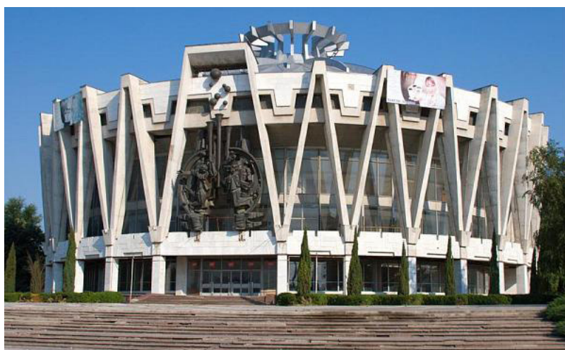
Fig. 7. Clădirea ciroului. Arhitecți Semion Șoihet, Albina Chiricenco. Sursa: https://wikimapia.org/59718/ro/Circul#/photo/358308 .
