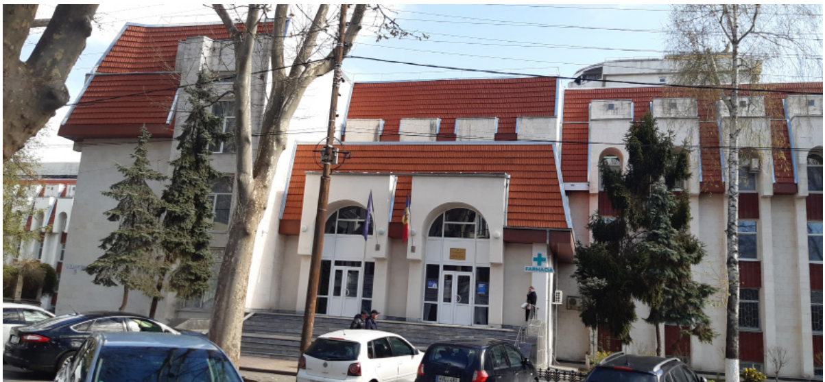
Fig. 5b. Policlinica Direcției curativ-sanitare de pe str. 31 august 1989. Arhitecți Ludmila Gofman, Ghenadie Jinkin, A. Țigankov (foto V. Șlapac).
