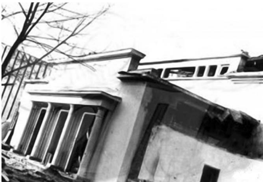
Fig. 9. Începutul demolării clădirii fostului Teatru „Scala”, Bălți, 1977 [16].
