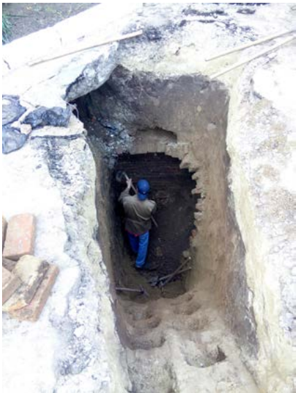
Fig. 18 Galeria de lângă sediul Procuraturii Cahul.
