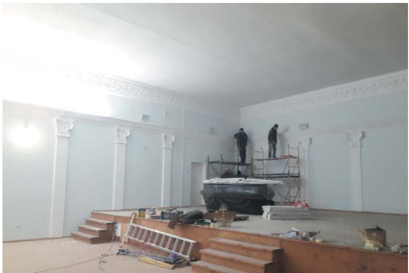
Sala Unirii, 2024, în proces de reparație
