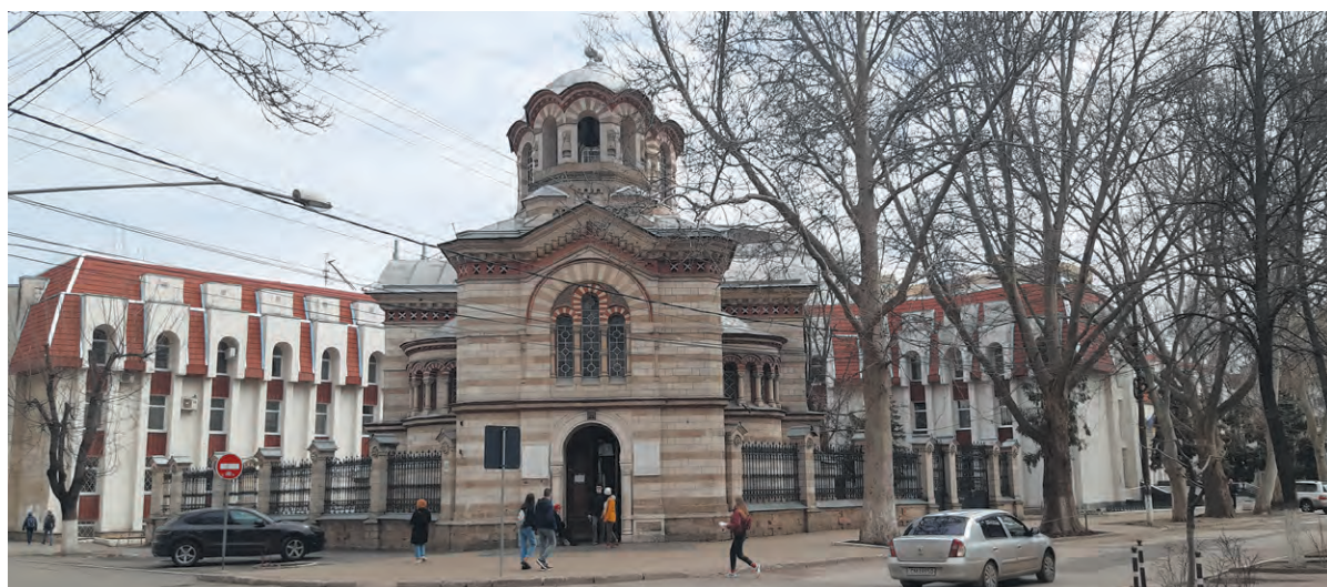
Biserica Sf. Pantelimon pe fundalul Policlinicii Căminului de Stat. Foto: M. Șlapac.
